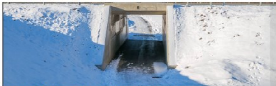
Pilt 2. Laagri moodasõidu alune jalakäijate tunnel, mis ühendab Veskimõldre I ja II etappi.
